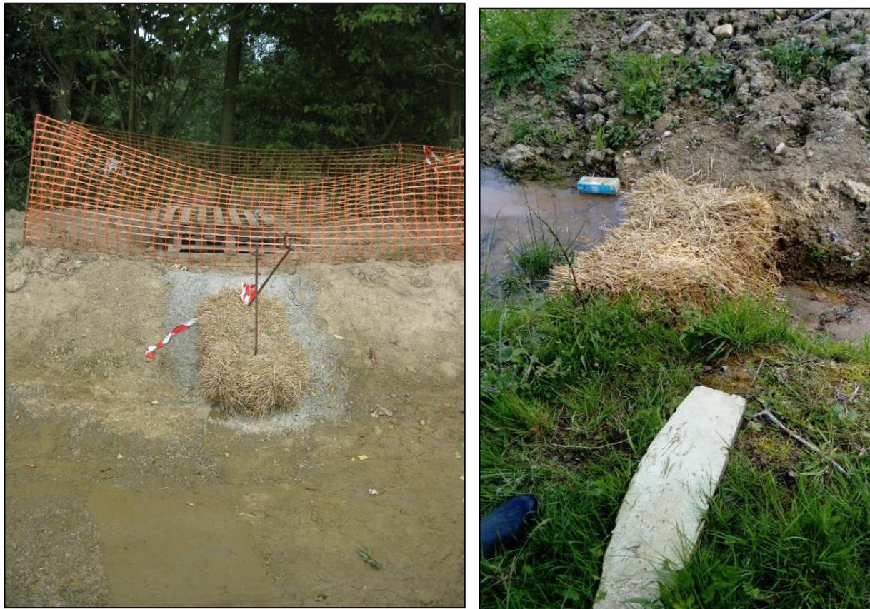
Figure 25 : Emplacements du filtre à particules fines (botte de paille) pendant la phase des travaux au niveau du bassin d'orage
