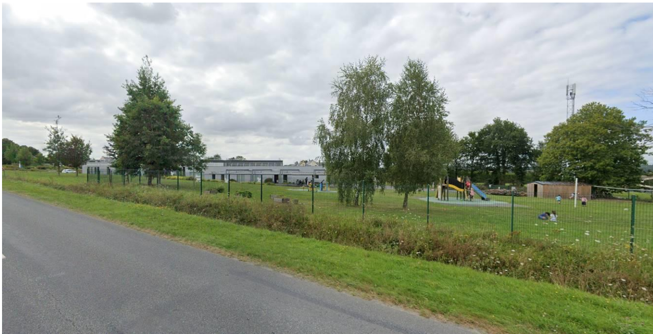
Anciens locaux de la communauté de communes du Porhoët accueillant le centre de loisirs, le RIPAM (gestion Ploërmel Communauté)
