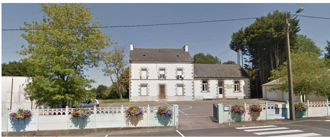
ZA 280, Le terrain situé à l'arrière de l'ancienne école publique pourrait accueillir des logements sociaux.
