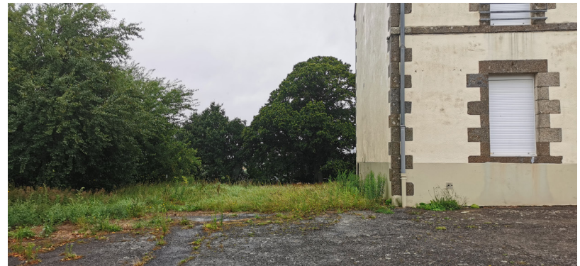
Vue du site depuis la cour de l'ancienne école
