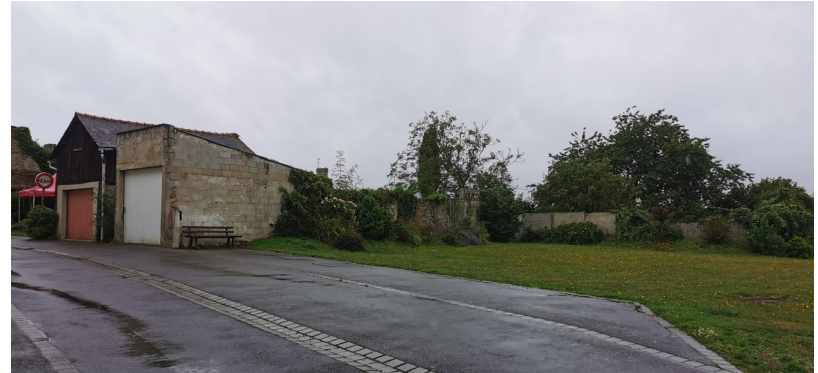
Vue depuis le haut de la rue du Presbytère, le site se trouve essentiellement derrière le mur (parcelle 135) + une petite bande devant le mur (parcelle 134)
