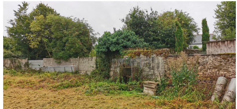
début du muret en pierre
